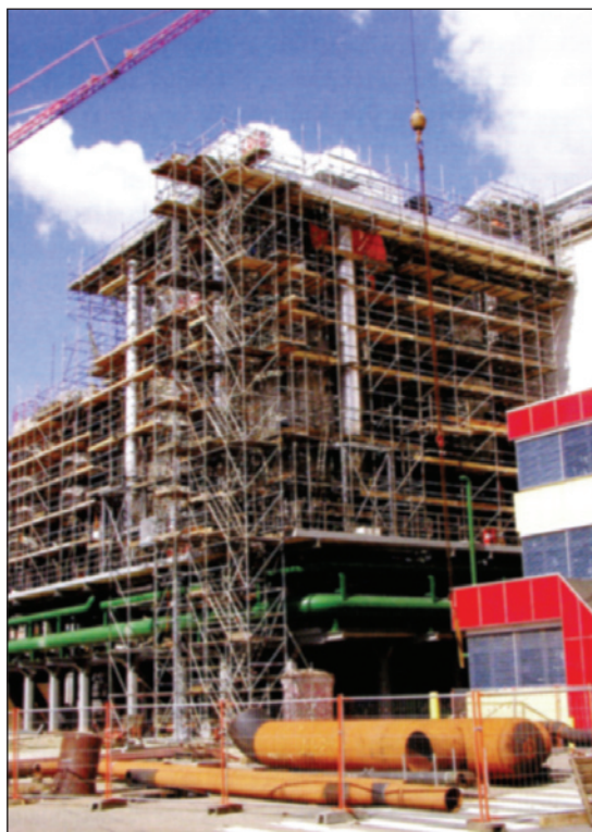
شکل ۲: ساخت اواپراتورهای تبخیر ۷ مرحله‌ای Volverlaten در تابستان ۲۰۰۸
